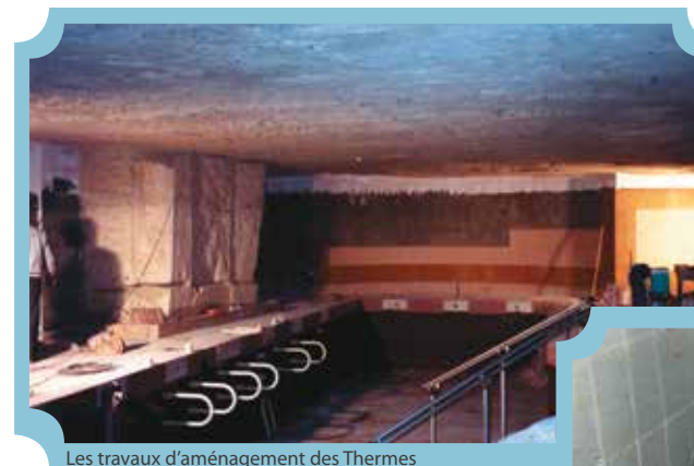
Les travaux d'aménagement des Thermes
